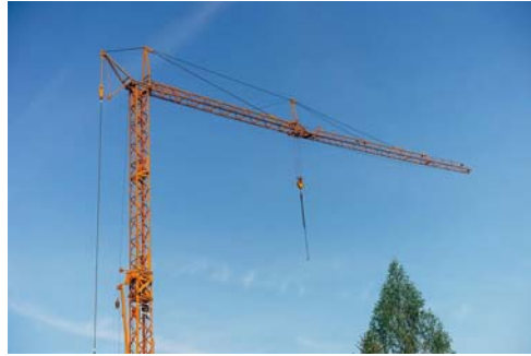
Jeřáb na stavbě: (Znojmo) (Ilustrační obrázek)
